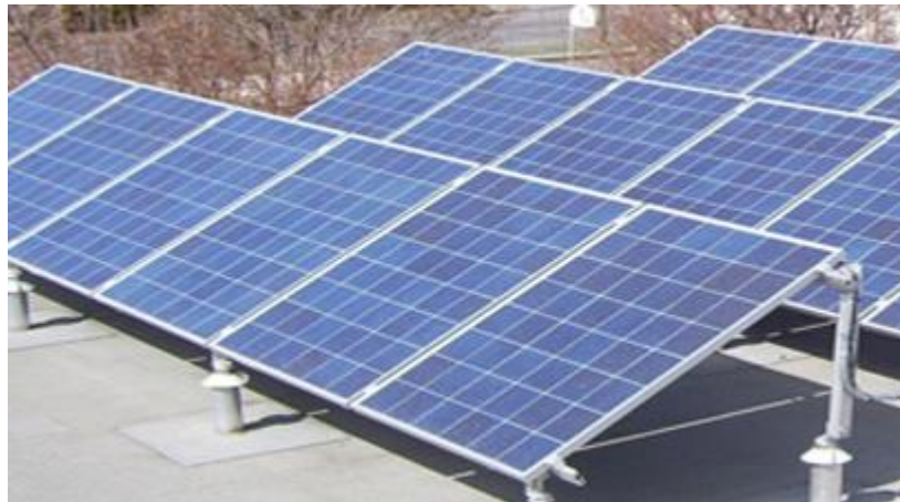
J3. Katuse kandekonstruktsioonide külge fikseeritud alused.
